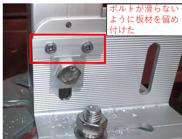
写真 5.6.2 補強あり接合部
