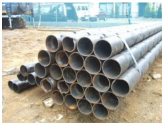
図 3.1.11 ⑨ アレイ支持物(鋼管杭)
