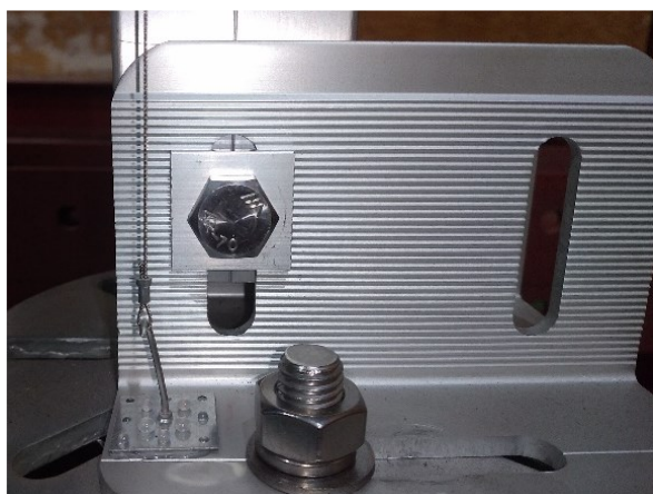
写真 5.6.1 補強なし接合部
