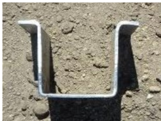
図 3.1.14 ⑨ アレイ支持物(型钢杭)
