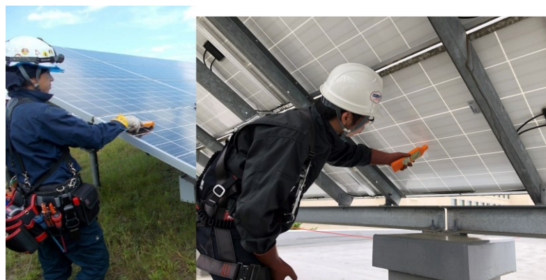
(c)モジュール表側からの探査 (d)モジュール裏側からの探査
