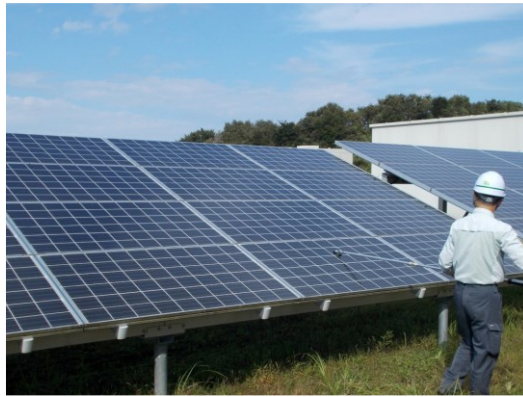
図 3-2 非接触電流測定による太陽電池ストリング配線の確認方法の概要
