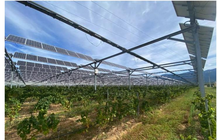
可動式太陽光発電システムのブドウ畑への設置例
