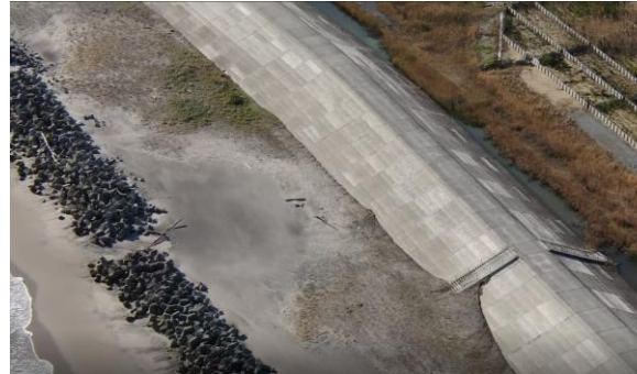
堤防付近の撮影画像
