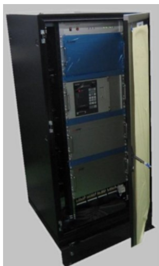
図 4-1-11 保護検出装置（三菱電機製、3 回線分×1 台）
