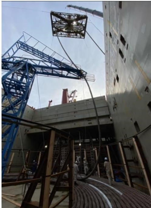
輸送船への巻き取り作業（実例）
