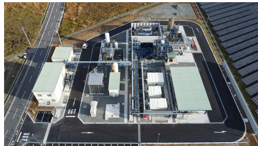
アンモニアプラント工事状況 (2024年12月) 19
