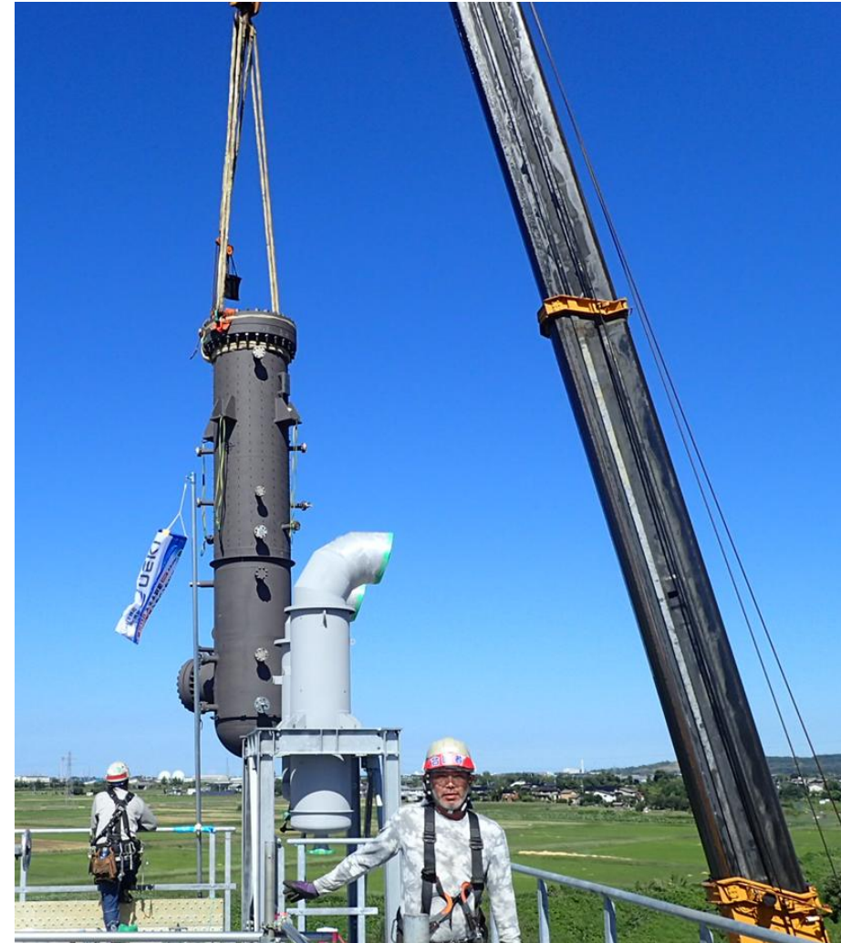
2024/9/24 ATR反応器据え付け
