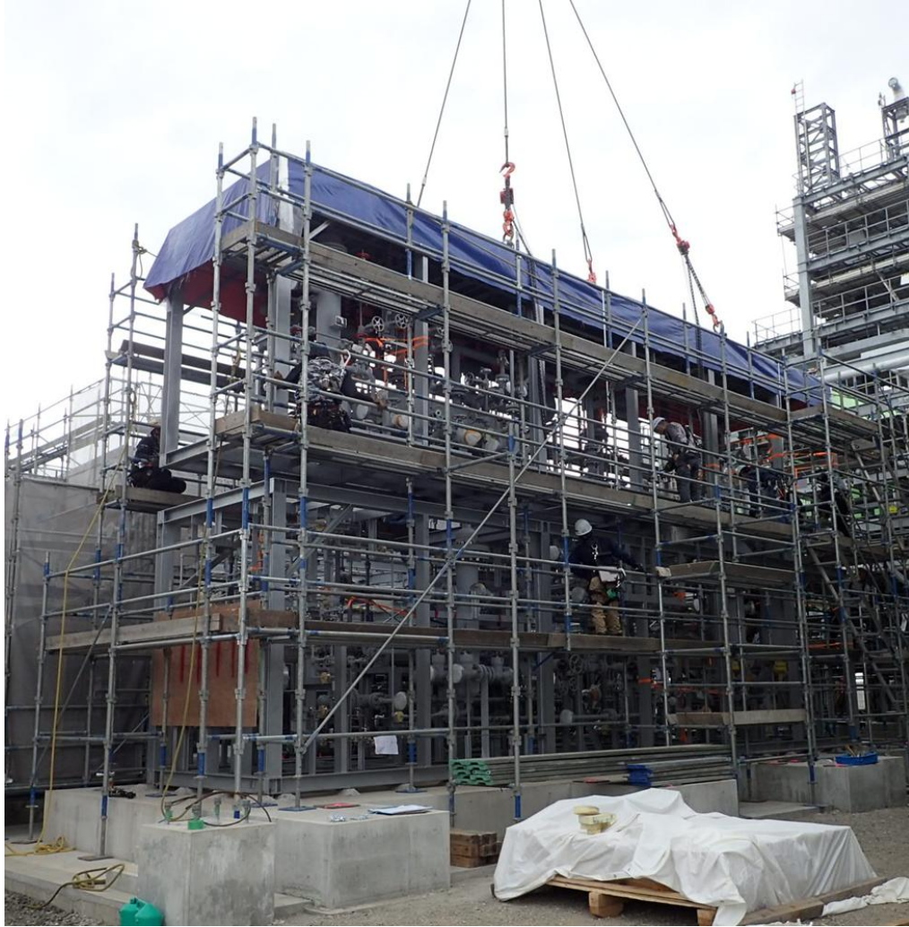
2024/9/14 アンモニア製造装置据え付け
