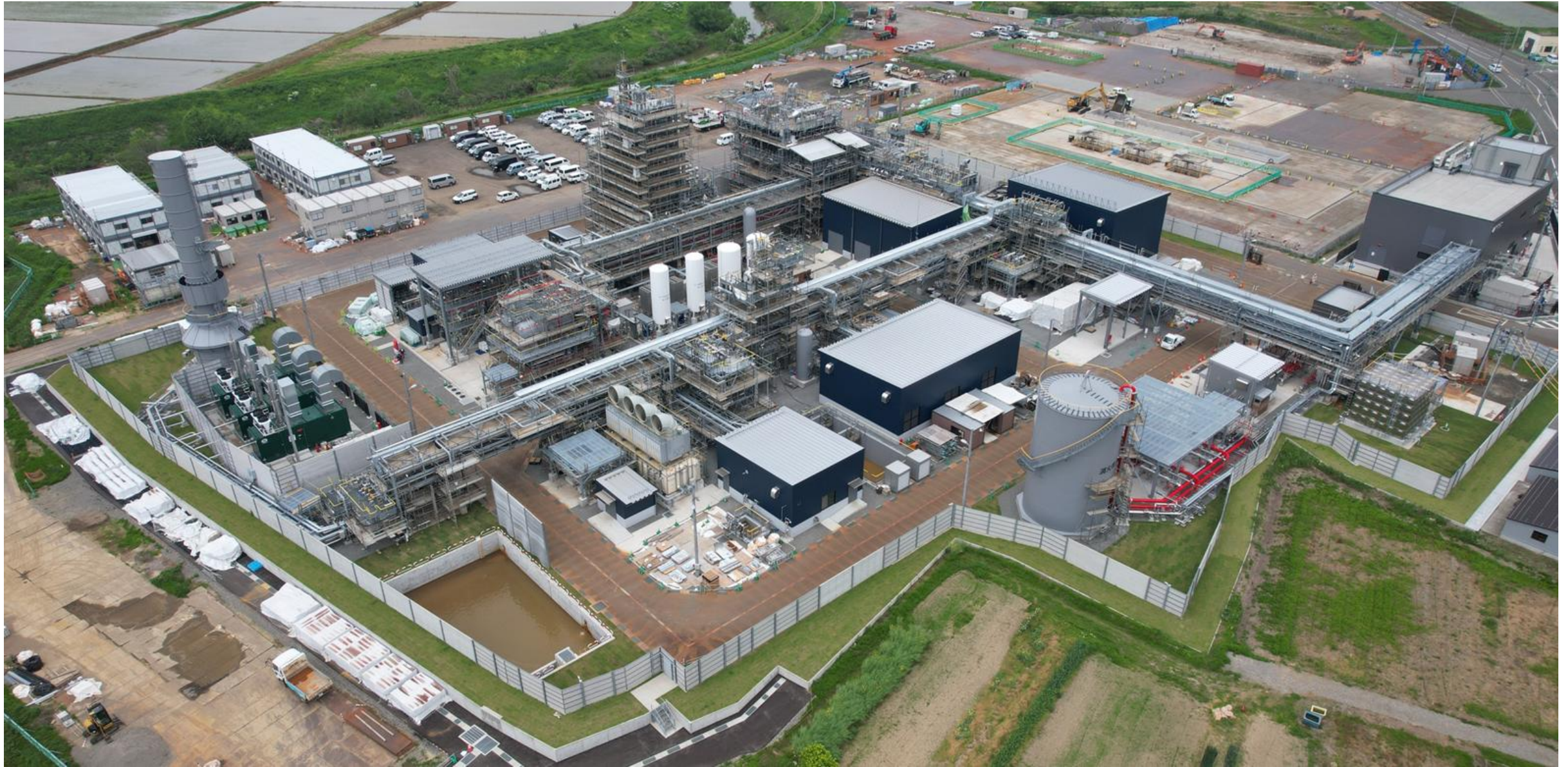
実証プラント建設状況（2025年5月20日撮影）
