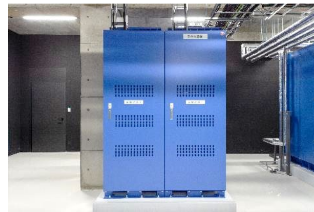
蓄電池(100kW-100kWh)
