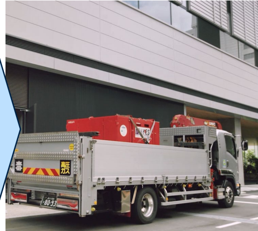
配管取外し・退場
