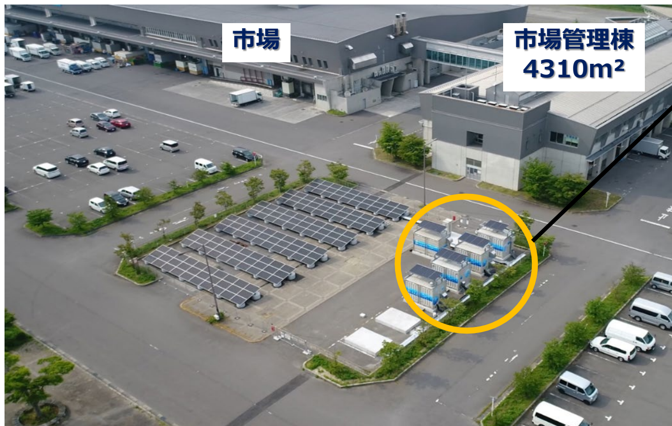
郡山市総合地方卸売市場
