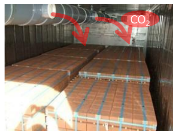
プレキャストコンクリートへ CO 2 固定状況
