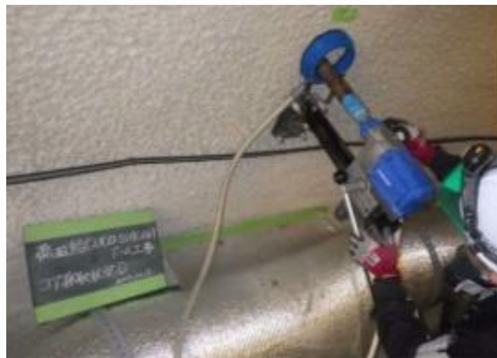
試作ドーム（東京）コア抜き状況
