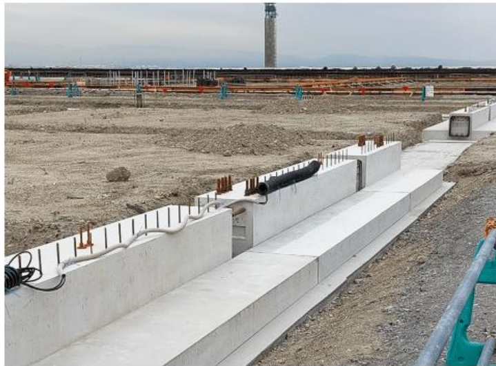
本開発材を適用した大阪・関西万博のイベントホール棟の基礎部材
