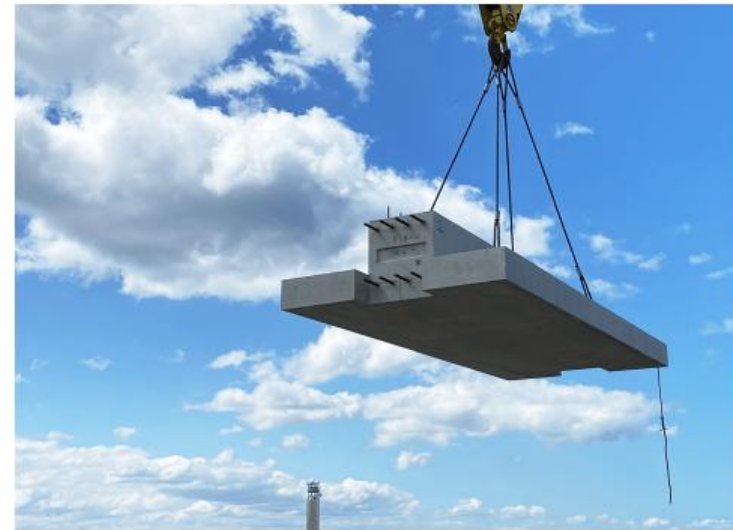
本開発材を適用した大阪・関西万博のイベントホール棟の基礎部材
