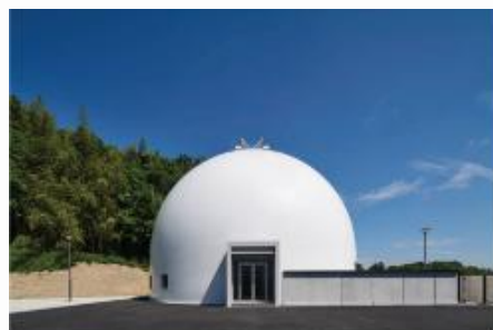
ドーム建築物 施工技術
