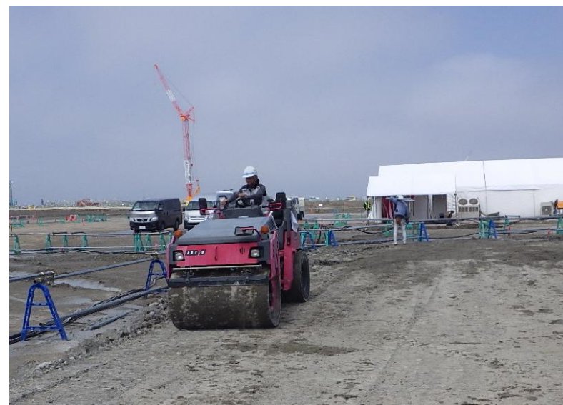
三菱未来館の完成イメージ（左）と地盤改良の施工状況（右）
