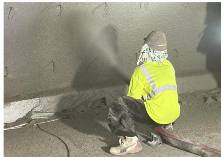
CUCO-SUICOMドーム吹付施工
