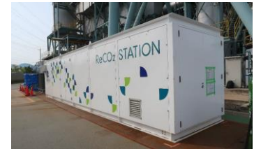
エア・ウォーター製 従来方式 小型CO 2 回収装置
