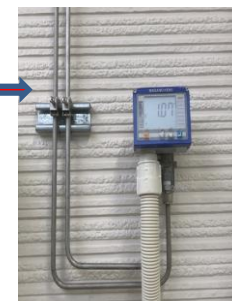
CO 2 配管及び監視用流量計
