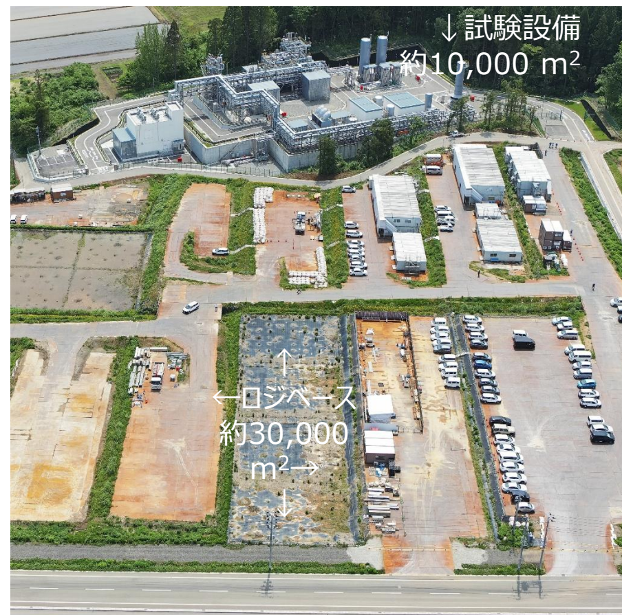
試験設備及びロジベース
