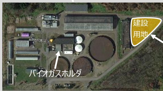
鹿追町環境保全センター(中鹿追施設)
