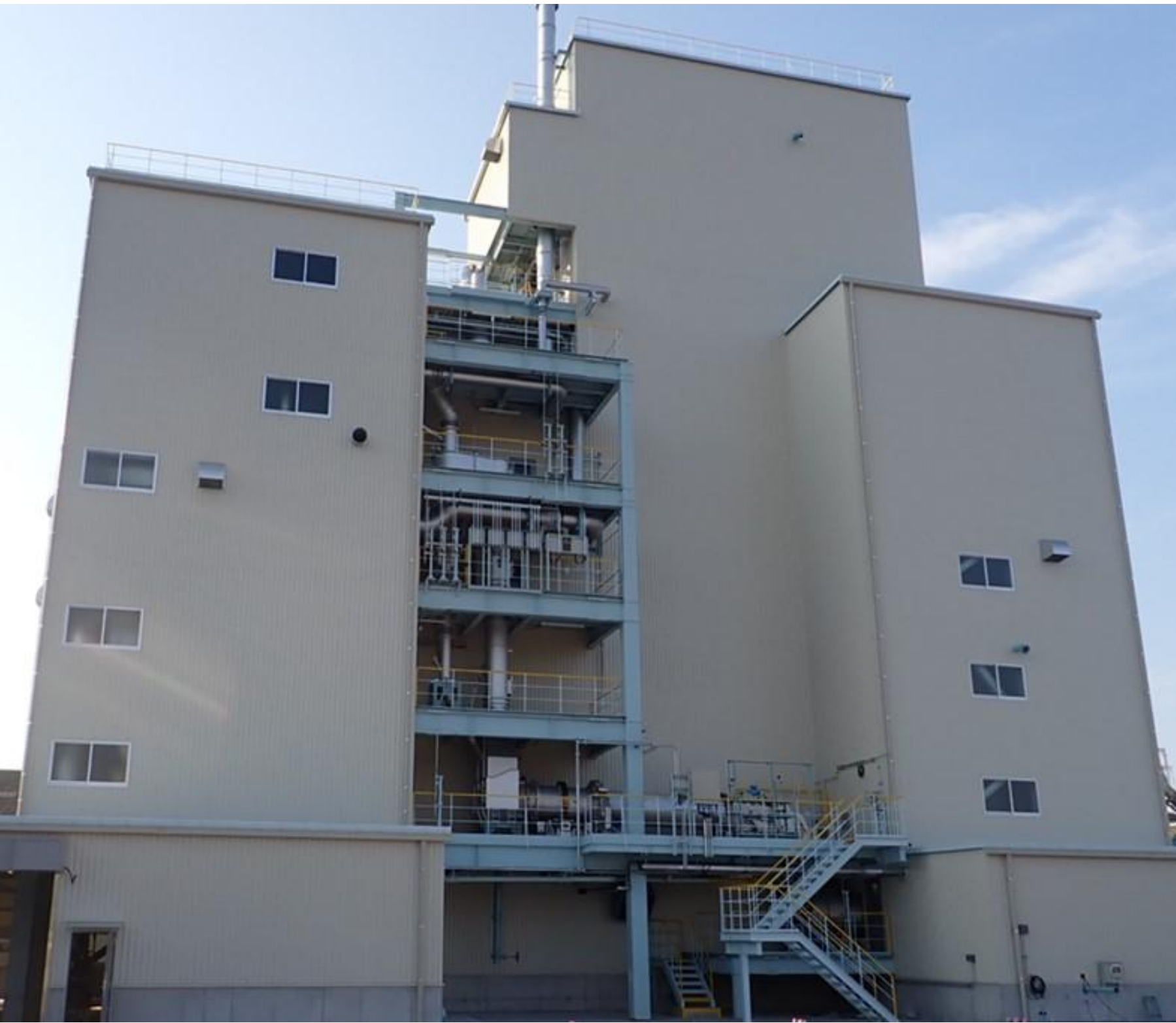
CO 2 回収型セメント製造実験実証機 原料送入量～300kg/h、セメントクリンカ製造量200kg/h CO 2 回収量～100kg/h (山口県山陽小野田市)
