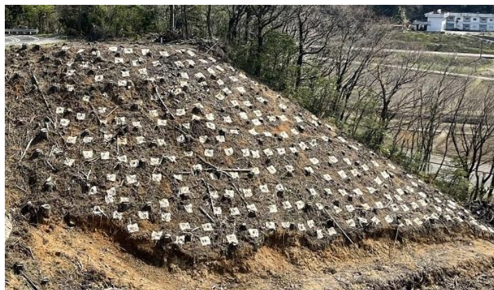
防草・獣害対策シート施工
