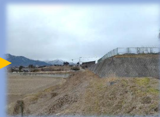
支障木（施工後）
