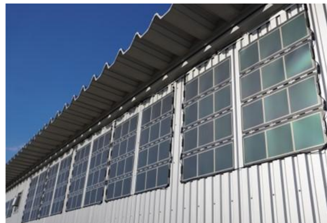
壁面への設置（南西面）
