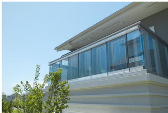
Fujisawa SST(神奈川県) バルコニー実証試験
