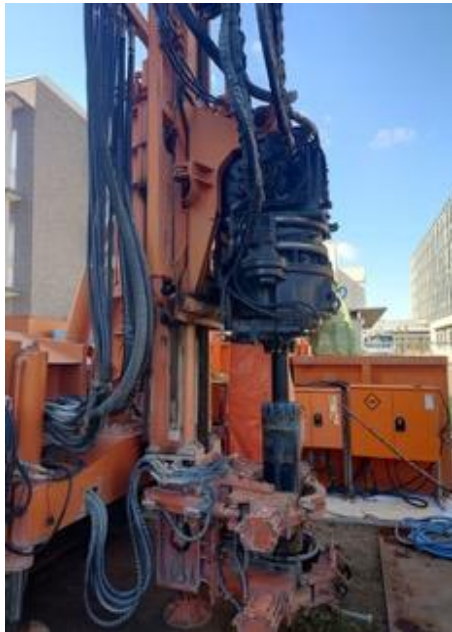
ソニック掘削機
