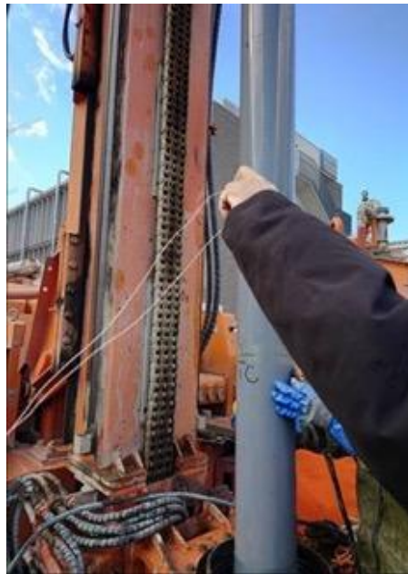
内管挿入時の熱電対設置作業
