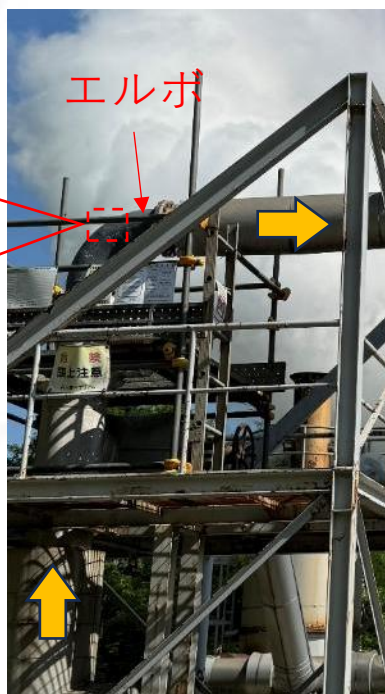
気水分離器上流側の配管レイアウトの変更状況
