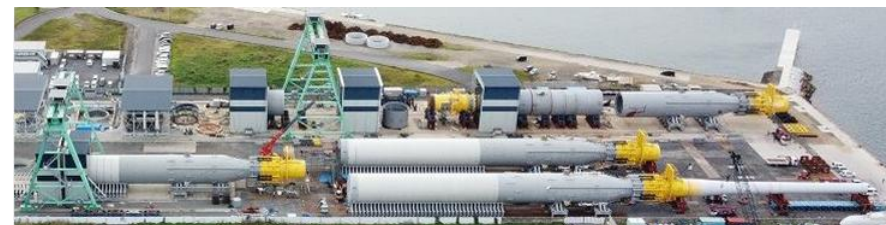
鋼製部・風車タワー連結
