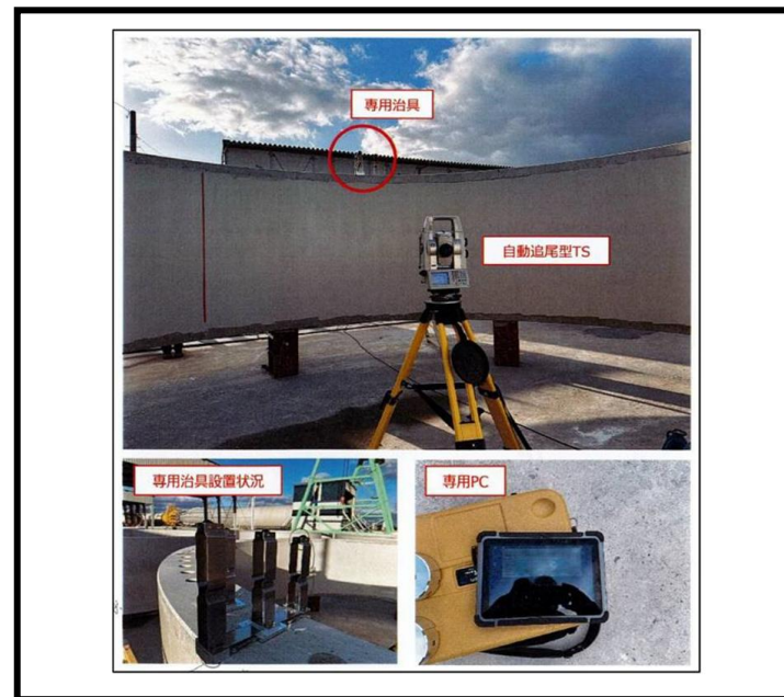
コンクリートリング出来高計測システム
