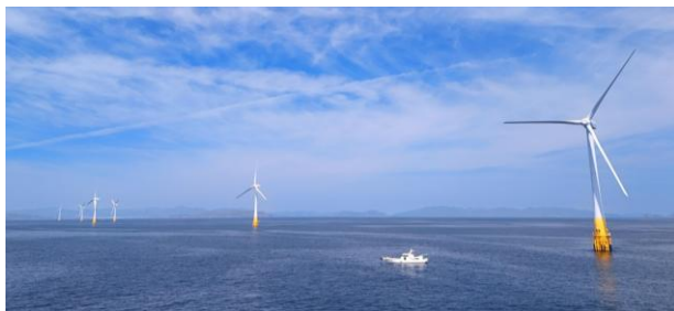
五島市沖洋上風力発電事業
