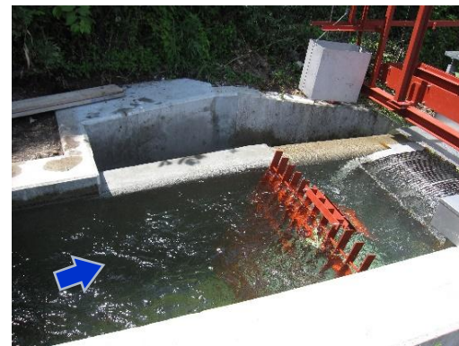
実証運転状況
