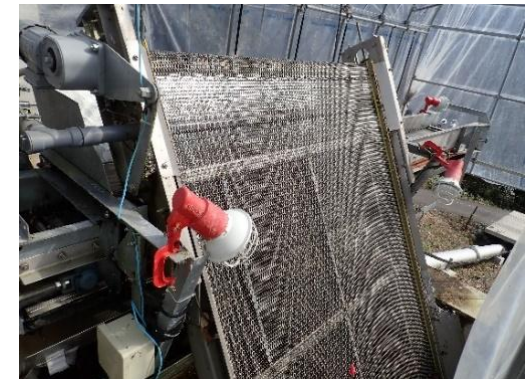
除塵機の凍結防止策の例
