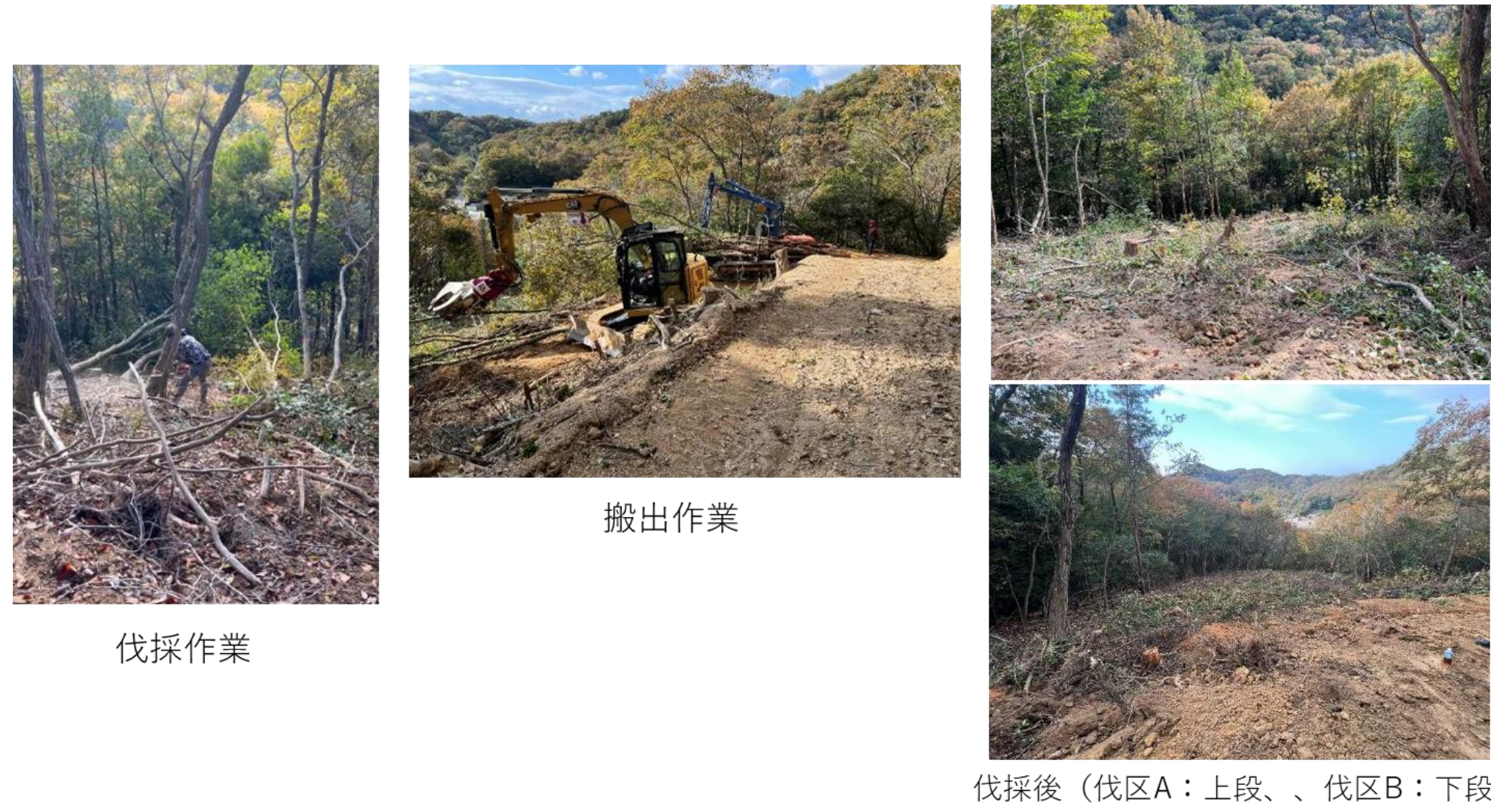
図3 伐採・搬出状況
