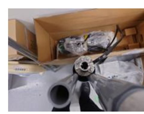
井戸管内の配管類 水中ポンプ・井水戻り管・観測装置用ガイド管
