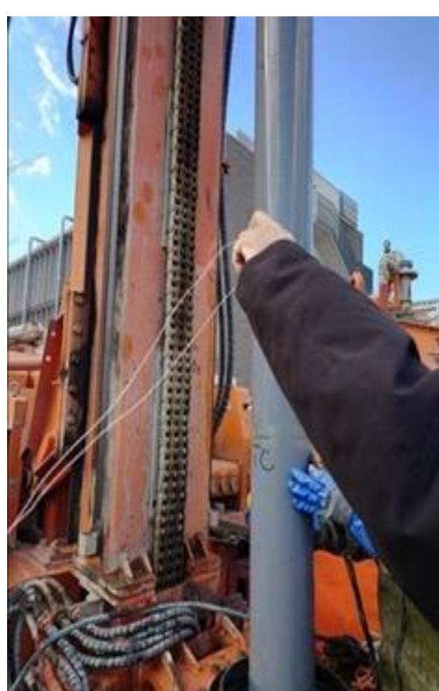
内管挿入時の熱電対設置作業
