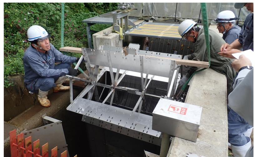
写真3 除塵機の設置作業風景
