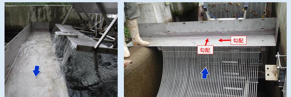
写真1 汲み上げる水を利用して(左)、塵芥を流すため、塵芥受けに勾配を設ける(右)
