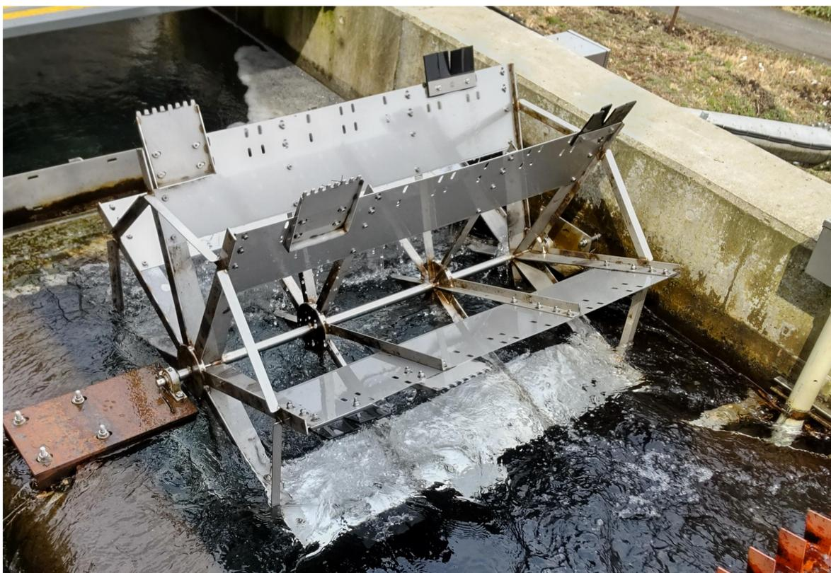
写真2 除塵機の全形 (実証トライアル中※上中山発電所設置)
