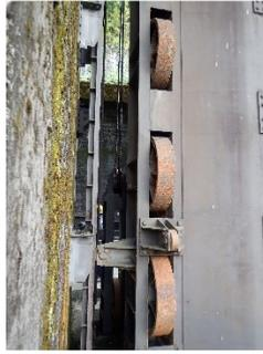
図 3.2.3 取水口ゲートとケーブル、ローラーの一例
