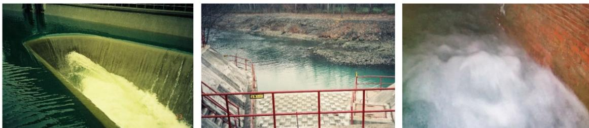
(1) ヘッドタンクと余水吐 (2) 余水路出口と合流河川 (3) 煉瓦積み余水路と高速射流
