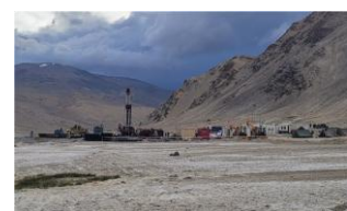
図 56 プガ渓谷のラダックでの地熱発電掘削の様子
