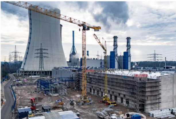
電解装置工事状況（Lingen @ドイツ）
