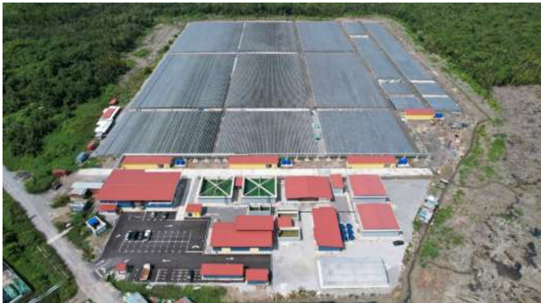
図 1. マレーシア、サラワク州、クチン市郊外に建設された微細藻類生産設備
