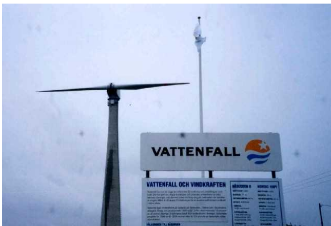
NASUDDEN II風車 定格出力：3 MW（定格風速：14.5 m/s） ロータ直径：80.5 m ハブ高さ：78 m カットイン風速：6.0 m/s カットアウト風速：25 m/s
