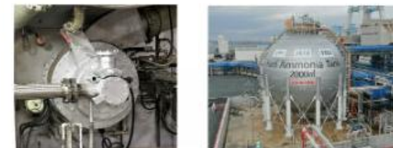
図2 実証用試験設備 (左：実証用バーナ 右：燃料アンモニアタンク)
