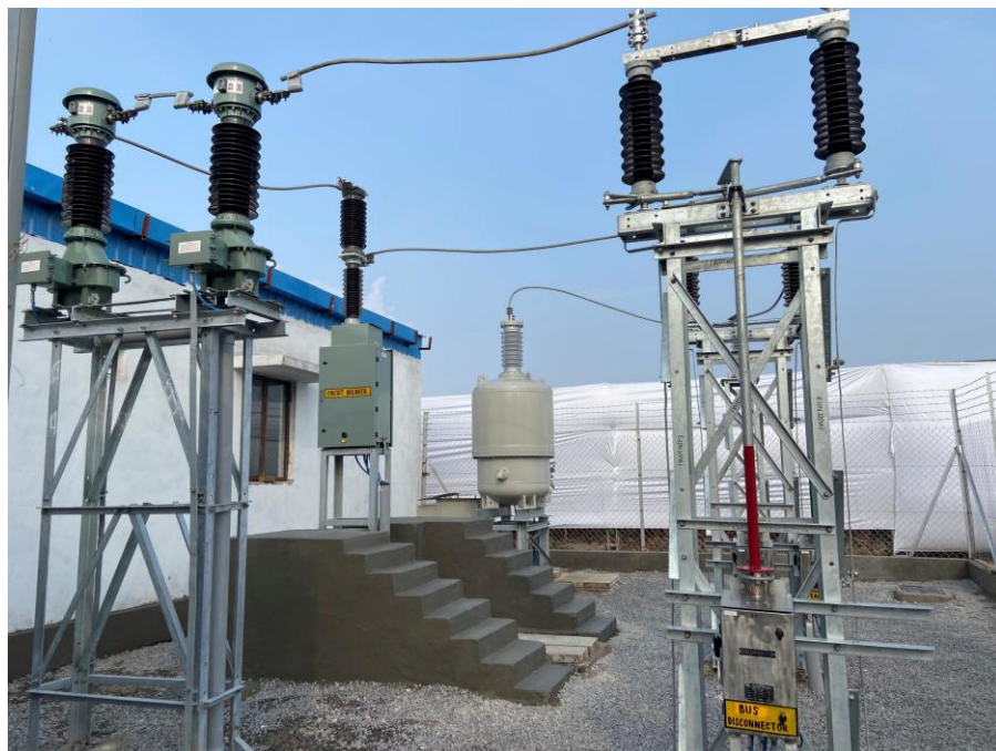
現地に設置したマイクロ変電所の外観
