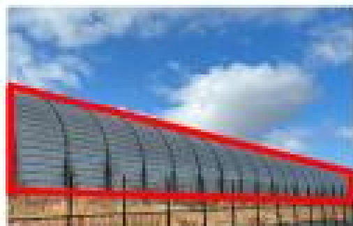
高速道路内の遮音壁の例（外壁） METI/CO高田氏より提供
