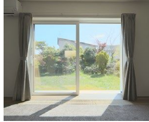
外窓交換(はつり工法)を実施
