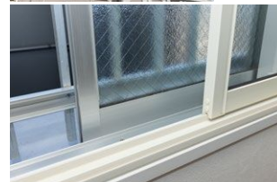
全住戸の内窓設置を実施
