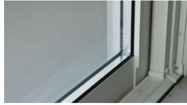
全住戸で外窓交換を実施
