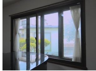
内窓設置を実施
