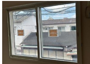
主居室の南側に内窓設置
