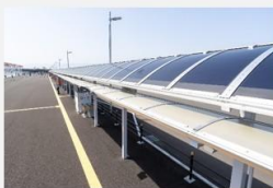
西ゲート・バスターミナルの屋根に設置されている様子（屋根の上で湾曲した形で実装）
