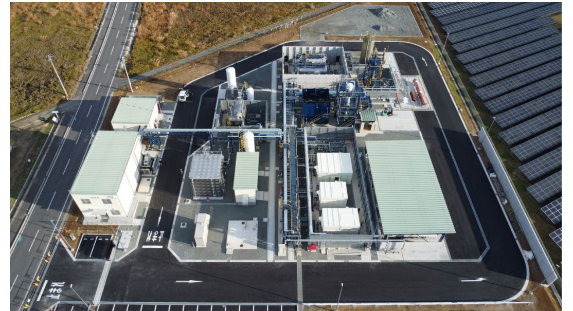
アンモニアプラント俯瞰図（2024年12月）
