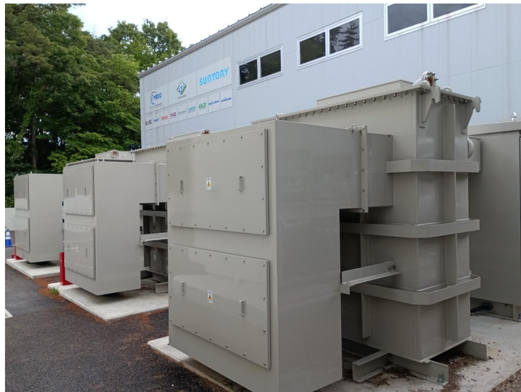
実証サイトへ据付状況
