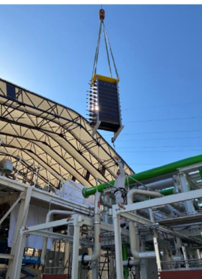
スタックの据付
