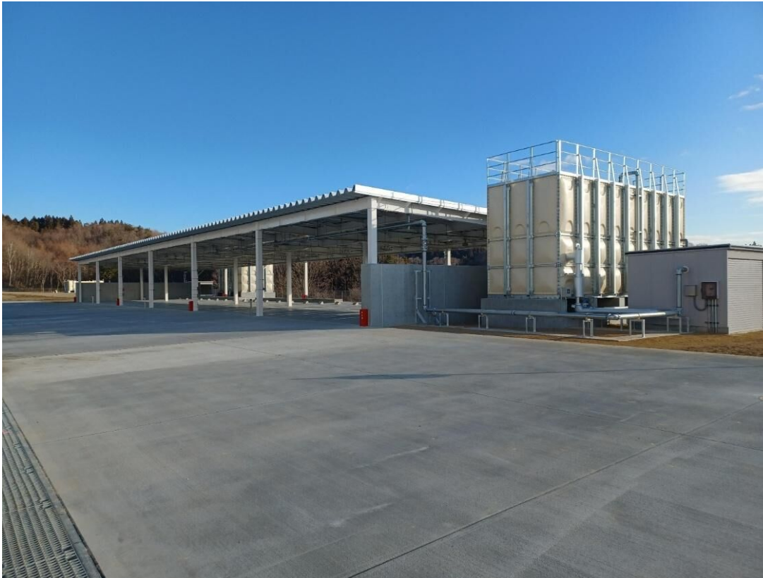
水素ガストレーラー庫
