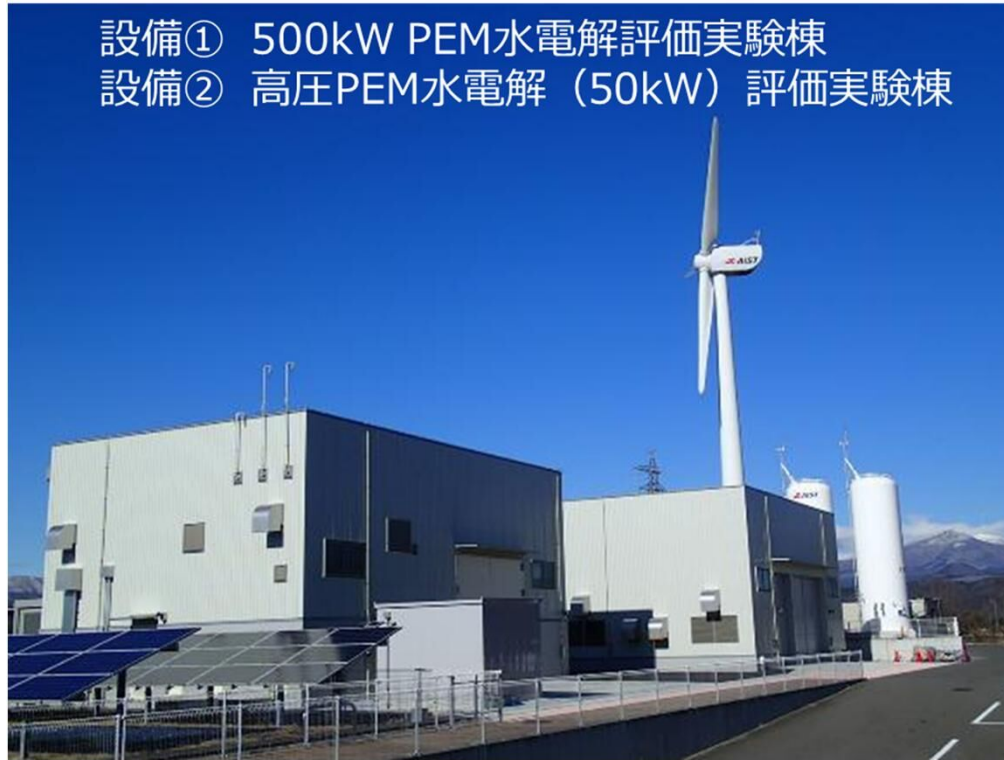
2023年度 専用建屋及び装置設置完了
