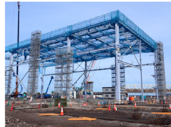
ボイルオフガス圧縮機建屋の建設状況 （'26/5/25撮影）
