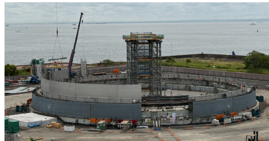
液化水素貯蔵タンク建設状況（'26/5/26撮影）
