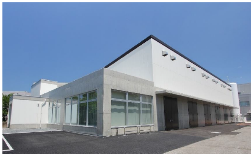
水素防爆実験室（6室） 液化水素貯槽（24,000 L）
