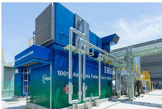
液体アンモニアを100%使用する2,000kW級ガスタービン「IM270」（IHI相生事業所内）
