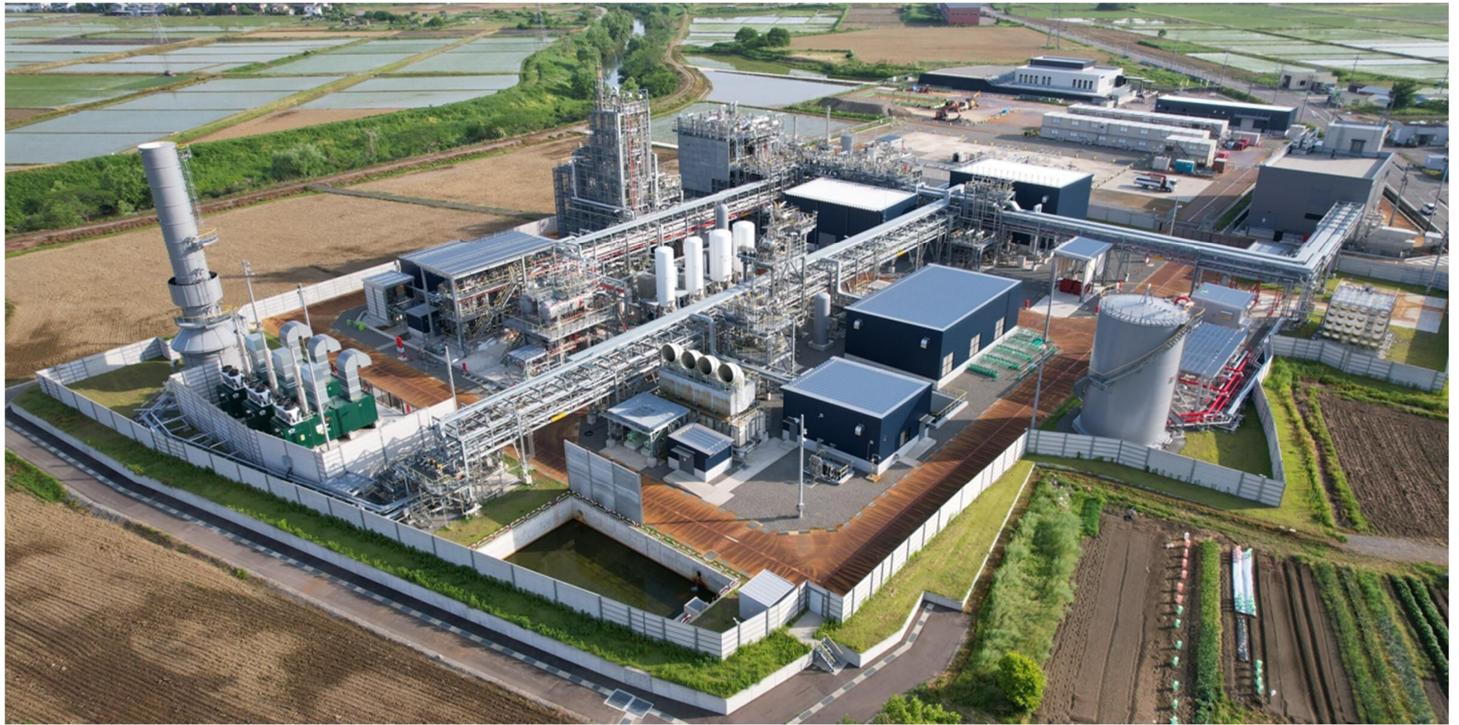
実証プラント建設状況(2026年5月26日撮影)
