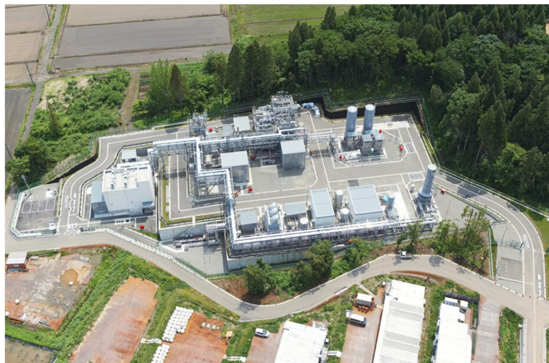
2025年6月撮影 (設備建設完了/試運転開始前)
