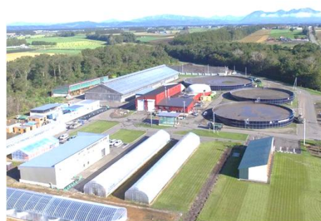
鹿追町環境保全センター (中鹿追施設)
