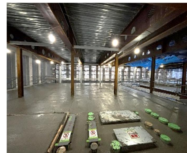
現場打ちコンクリート 施工完了
