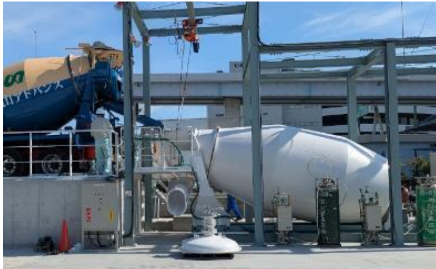
炭酸化粒状骨材（CP骨材）製造設備
