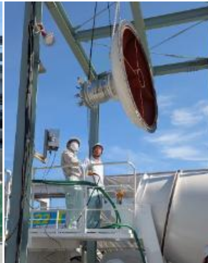
密閉蓋取付作業
