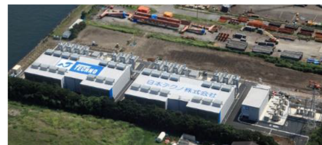
110MW 発電プラント@袖ヶ浦
