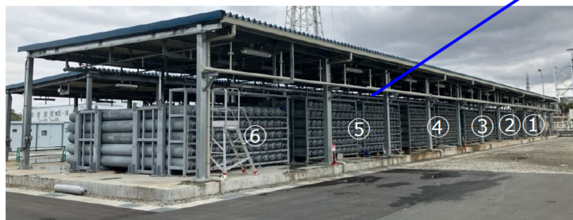
全6基の蓄圧器据付完了
